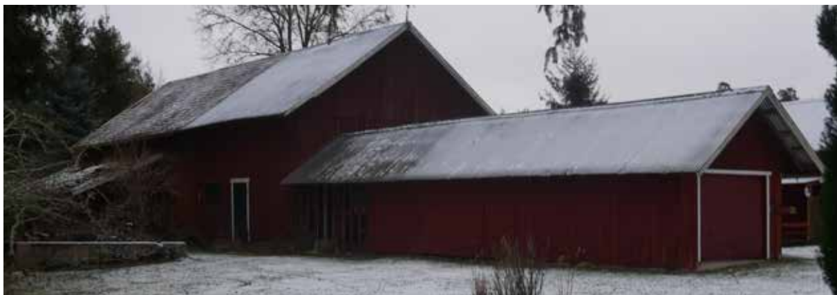
Ladugården - fasad mot norr
