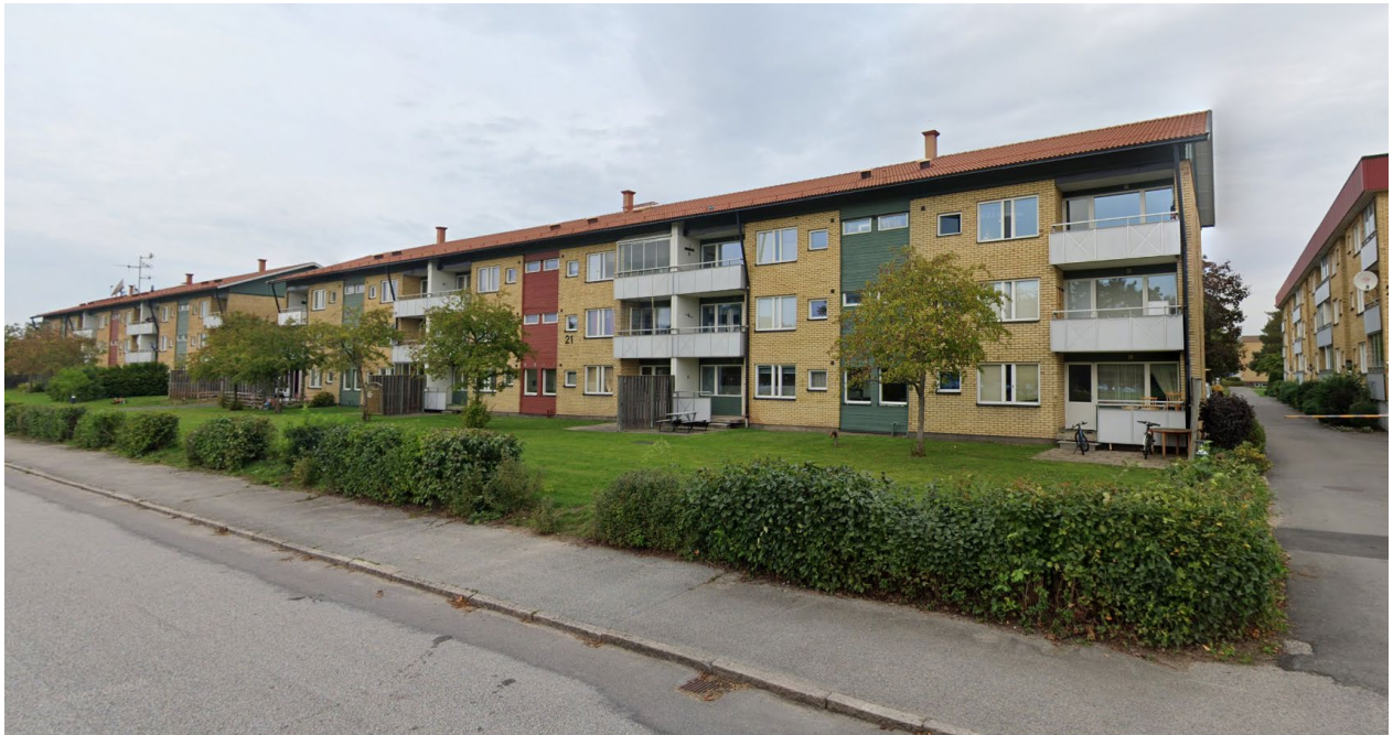
Figur 11. Ett av de 12 lamellhusen inom planområdet.
