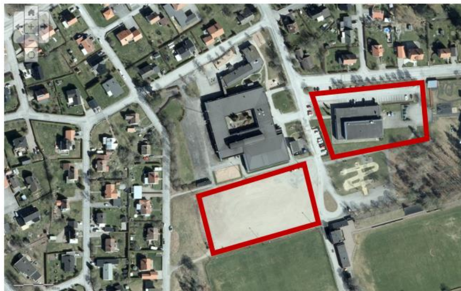
Figur 2. Föreslagna platser för planerad förskola och badhus. Befintlig badhus i högra rektangeln som avses rivas.
