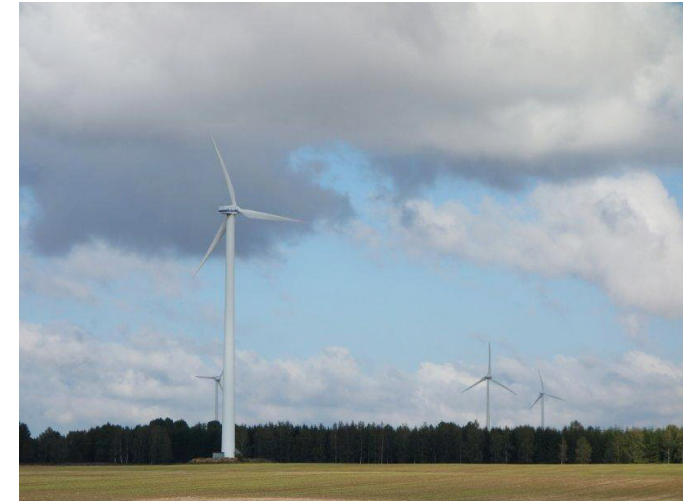
Vindkraftverk utanför Götene
